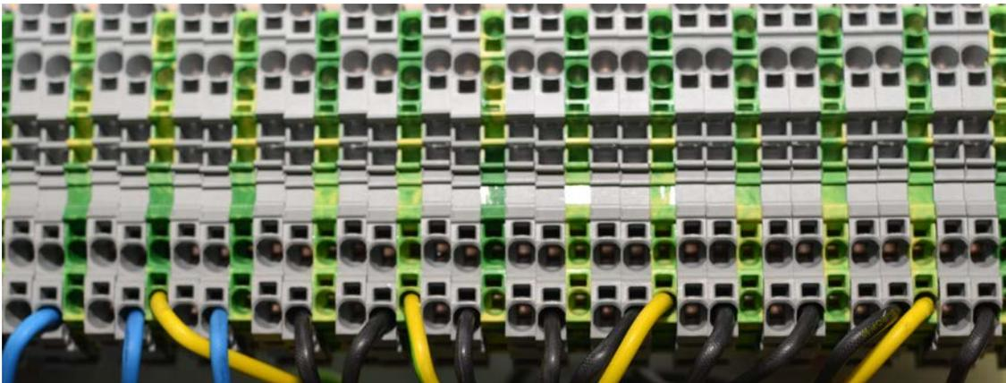
Рисунок 2.3.9. Верхняя панель с клеммами выводов RPCM DELTA (фрагмент).
